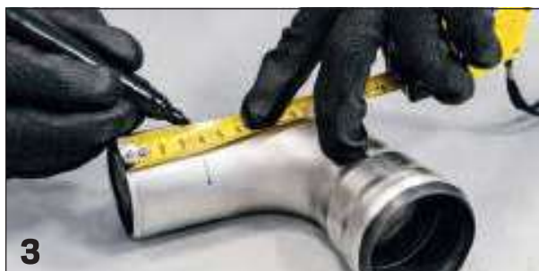
3 Marcatura quota d'innesto / Marking the insertion's depth
