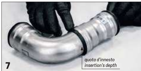
7 Controllo completo inserimento del tubo nel bicchiere / Check of complete pipe's insertion into the fitting
