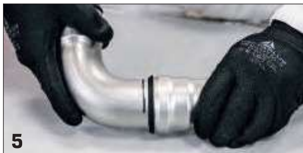
5 Inserimento tubo nel raccordo / Inserting of the pipe into the fitting
